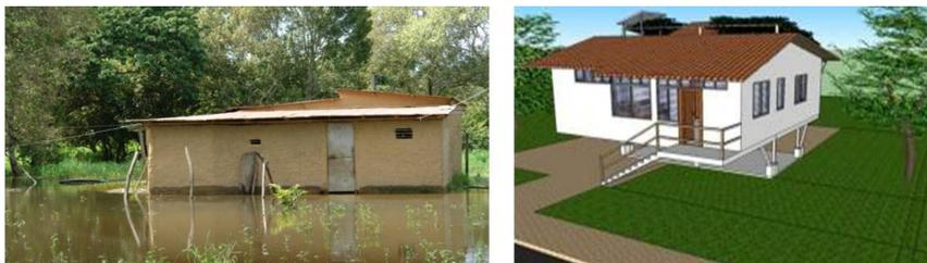
**Figura 4.** A la izquierda, vivienda bajo el efecto de la inundación en el estado Apure, en la vía Buzual-San Fernando de Apure, en julio de 2005. A la derecha el concepto VIDA, propuesto por Mendoza y col. (2012); en este modelo de vivienda la separación del sustrato evitaría en parte los daños por inundación.
