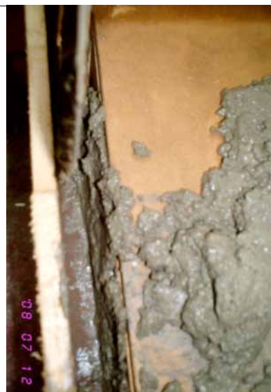
Figura 4 Aplicación de la primera capa de mortero
