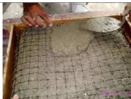
Figura 5 Aplicación de la primera capa de malla
