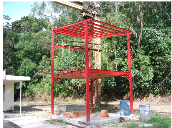
Figura 17 Construcción prototipo en la Planta Experimental
