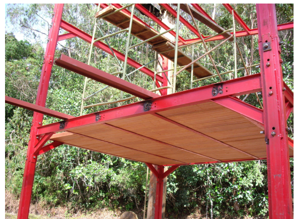
Figura 18 Detalle construcción prototipo en la Planta Experimental
