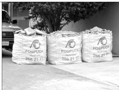
Figura 8: Sacos para la recolección de escombros
