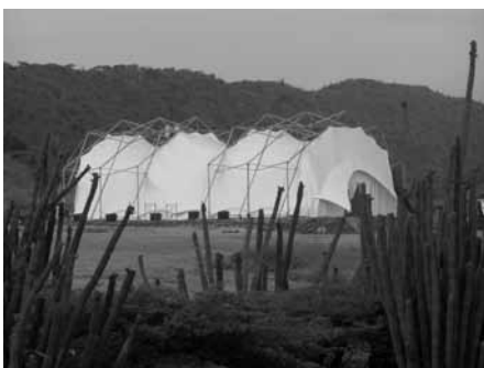
Figura 12 Pabellón itinerante utiliza dos módulos transformables con perfiles de acero
