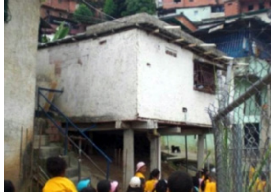
Foto 9 - Contención falsa al construir paredes sólo para ocultar los pórticos de la estructura Fotografía: G.L.S., 2013-2014.
