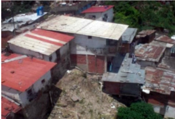
Foto 8 - Contención por paredes de bloques de cemento Fotografía: G.L.S., 2013-2014.
