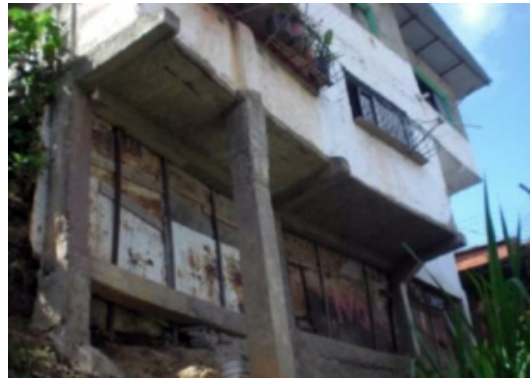
Foto 9 - Contención falsa al construir paredes sólo para ocultar los pórticos de la estructura Fotografía: G.L.S., 2013-2014.
