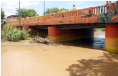
Figura 8. Puente Guzmán Blanco de la avenida Bermúdez de Cumaná, estado Sucre, Venezuela.
