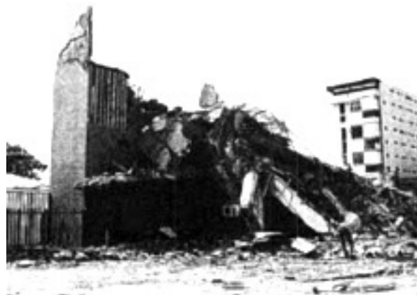
Figura 4. Edificio Miramar en la ciudad de Cumaná colapsado después del sismo de Cariaco de 1997 (irónicamente sede de Seguros la Seguridad)
