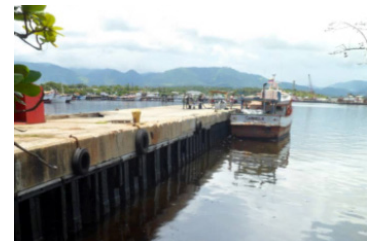
Figura 10. Muelle de Cariaco de concreto reforzado en el estado Sucre, Venezuela
