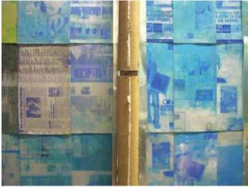
Figura 13. Superficie vertical constituida por componentes estructurales y de revestimiento
