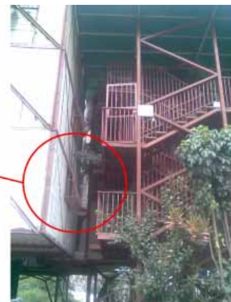
Imágenes 27b. Las ventanas de cocina se ubican hacia el interior de la edificación en edificios de Urb. La Esperanza, Casalta III.
