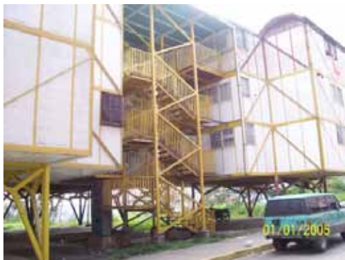
Figura 7. Núcleo de Escaleras abiertas. Urb. La Esperanza, Casalta. Caracas.
