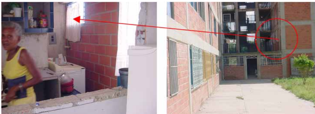
Imágenes 26a y 26b. Área de cocina en apartamento de Urb. Mata de Coco, Valles del Tuy. En estos edificios las ventanas de la cocina se ubican hacia el interior de la edificación.
