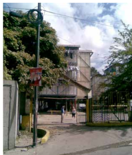
Imagen 25. Cierre de entrada a la urbanización desde lindero con la calle, Urb. La Esperanza, Casalta, Caracas.
