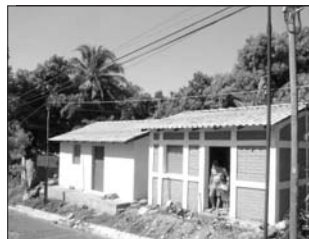
Figura 6: Viviendas con techos experimentales realizadas por FUNDASAL en El Salvador en el marco del proyecto "10x10". (Foto: I. Oteiza).
