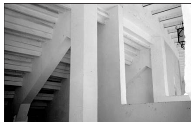
Foto 6: Vista de vigas y columnas de soporte de la gradería, Maestranza de Maracay.
