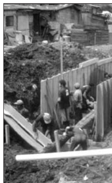
Figura 2: Mejoramiento de favela utilizando componentes prefabricados de “argamasa armada”. (Foto: P.E. Fonseca).
