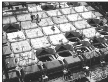
Foto 22: Ampliación del Museo de Bellas Artes de Caracas. Losas prefabricadas ya colocadas.
