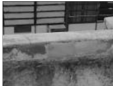
Foto 17 Prueba de mortero
