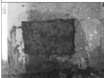
Foto 14 Prueba de mortero
