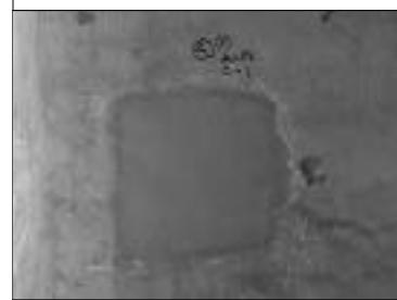
Foto 16 Prueba de mortero
