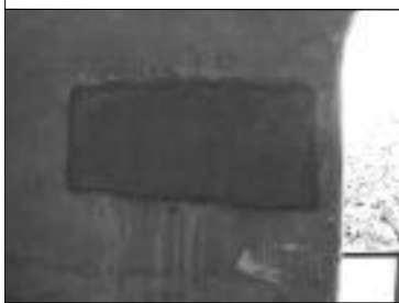
Foto 15 Prueba de mortero
