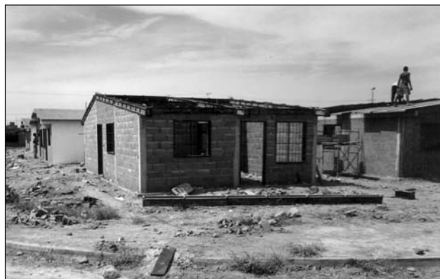
Foto 4 Estructura en concreto armado
