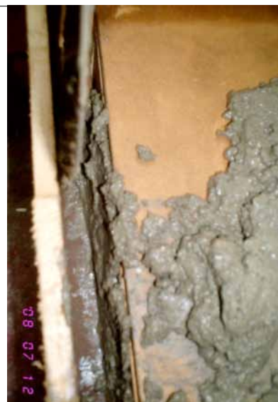
Figura 4 Aplicación de la primera capa de mortero
