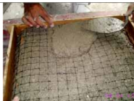
Figura 5 Aplicación de la primera capa de malla
