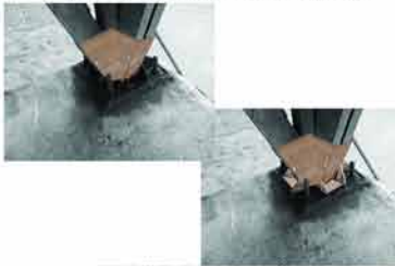
COLOCACION DE PLANTAS DE ACERO PARA EL REFORZO DE LAS BASES
