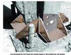
COLOCACION DE PLANTAS DE ACERO PARA EL REFORZO DE LAS BASES
