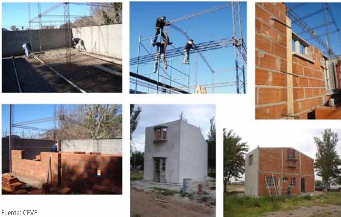
Fotos 1,2,3,4,5 y 6: Proceso constructivo Sistema UMA
