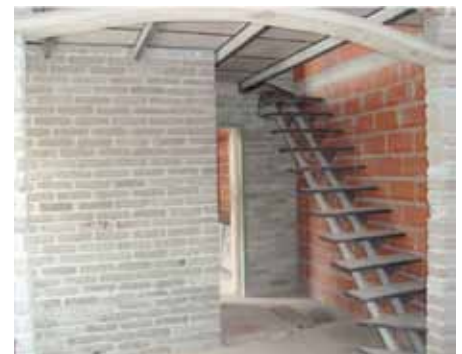
Foto 9: Muro de ladrillo de PET
