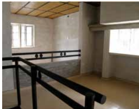
Foto 16: Interior. Planta alta
