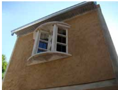
Foto 12: Ventana de hormigón
