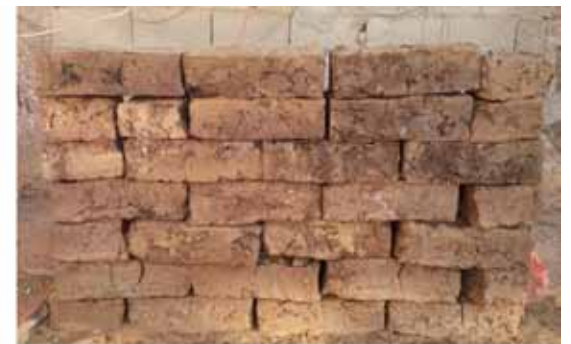
Aproximación de levantamiento de pared.
