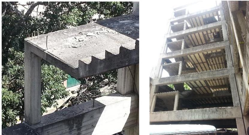
Figura19. Columnas que sirven de apoyo para el descanso de la Escalera. Fuente: elaboración propia, 2014
