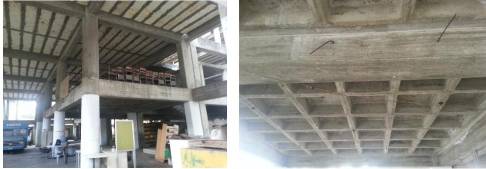
Figura22. Losa Reticular del Módulo A. Fuente: elaboración propia, 2014.
