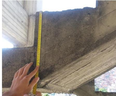
Figura20. Medición de Contrahuella del Escalón. Fuente: elaboración propia, 2014
