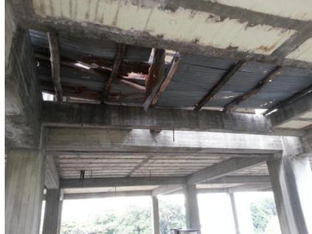
Figura14. Espacios Vacíos en Losa del módulo C. Fuente: elaboración propia, 2014.
