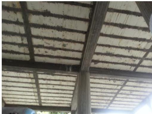
Figura23. Losa Nervada del Módulo A. fuente: elaboración propia, 2014.
