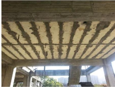
Figura13. Losa Nervada de Techo en el módulo C. fuente: elaboración propia ,2014.
