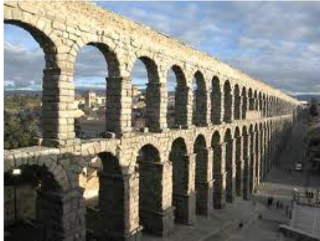
Figura 2.1: Acueducto de Roma.
