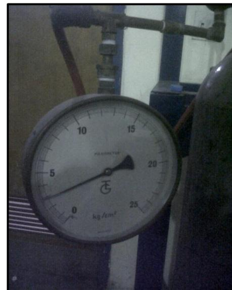
**Fig. 3.25** Manómetro para medir la presión de agua suministrada. Fuente: Propia.
