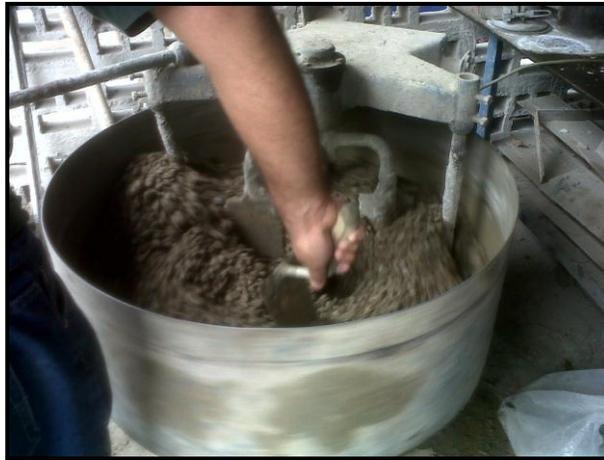
**Fig. 3.10** Mezclado de los componentes del concreto con mezcladora de eje vertical. (Se evidencia que la mezcla se encuentra homogénea).
