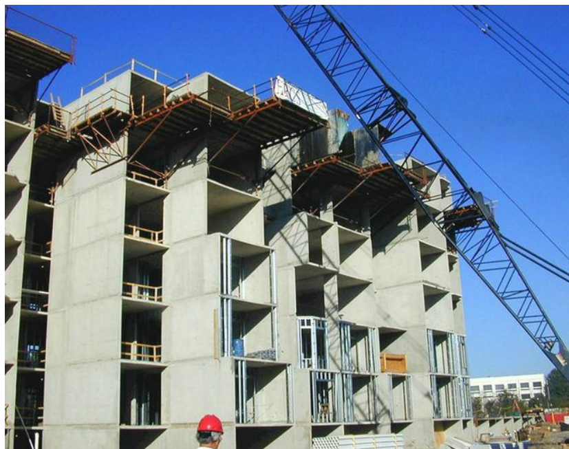
Fig 2.1: Edificación construida mediante sistema de encofrado tipo túnel.
