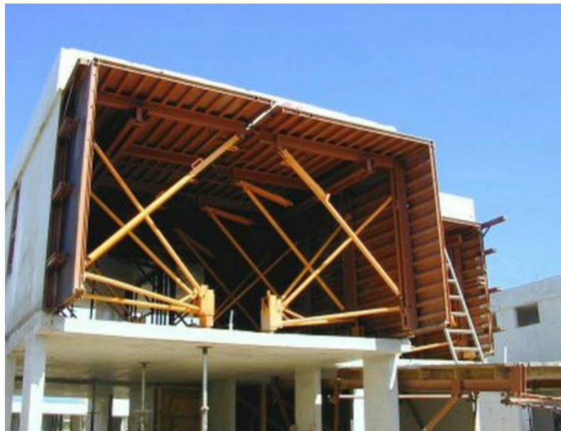
Fig 2. 2: Encofrados para sistemas tipo túnel. Fuente: Quintero y Ussher (2011).
