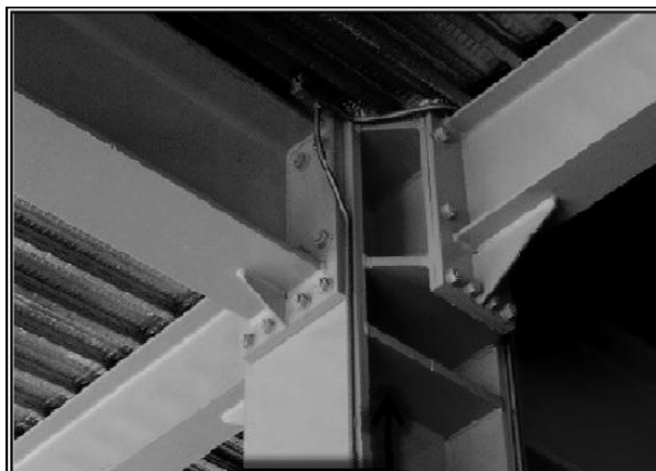
Fig. 13. Plancha de continuidad. (Nuñez, 2012)
