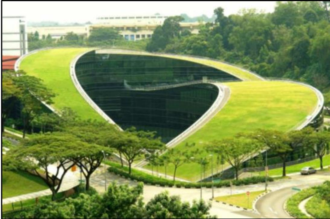
Figura 7. Ejemplo de techo verde del tipo Extensivo
