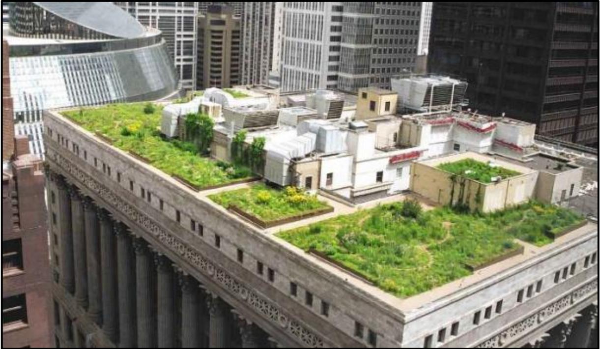
Figura 6. Ejemplo de techo verde del tipo Semi-intensivo
