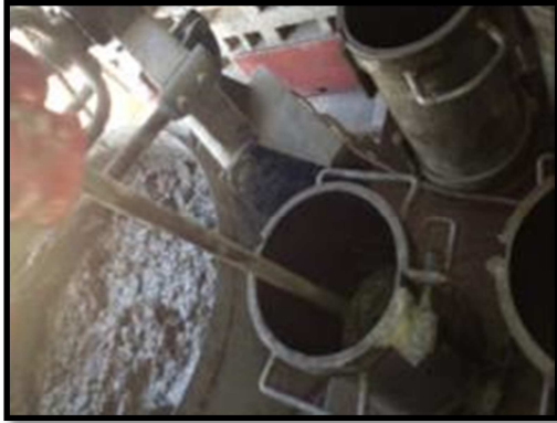
Figura 11. Primera capa compactación con barra normalizada. Fuente: Elaboración propia. Fecha: 07-Abr-2014
