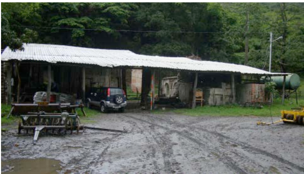
Fotografía 22: Trapiche El Ingenio. Fachada norte.
