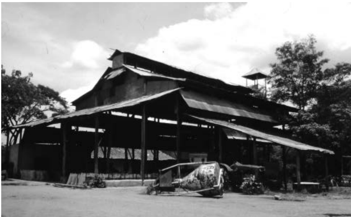
Fotografía 38: Central Sicarigua. Vista general.
