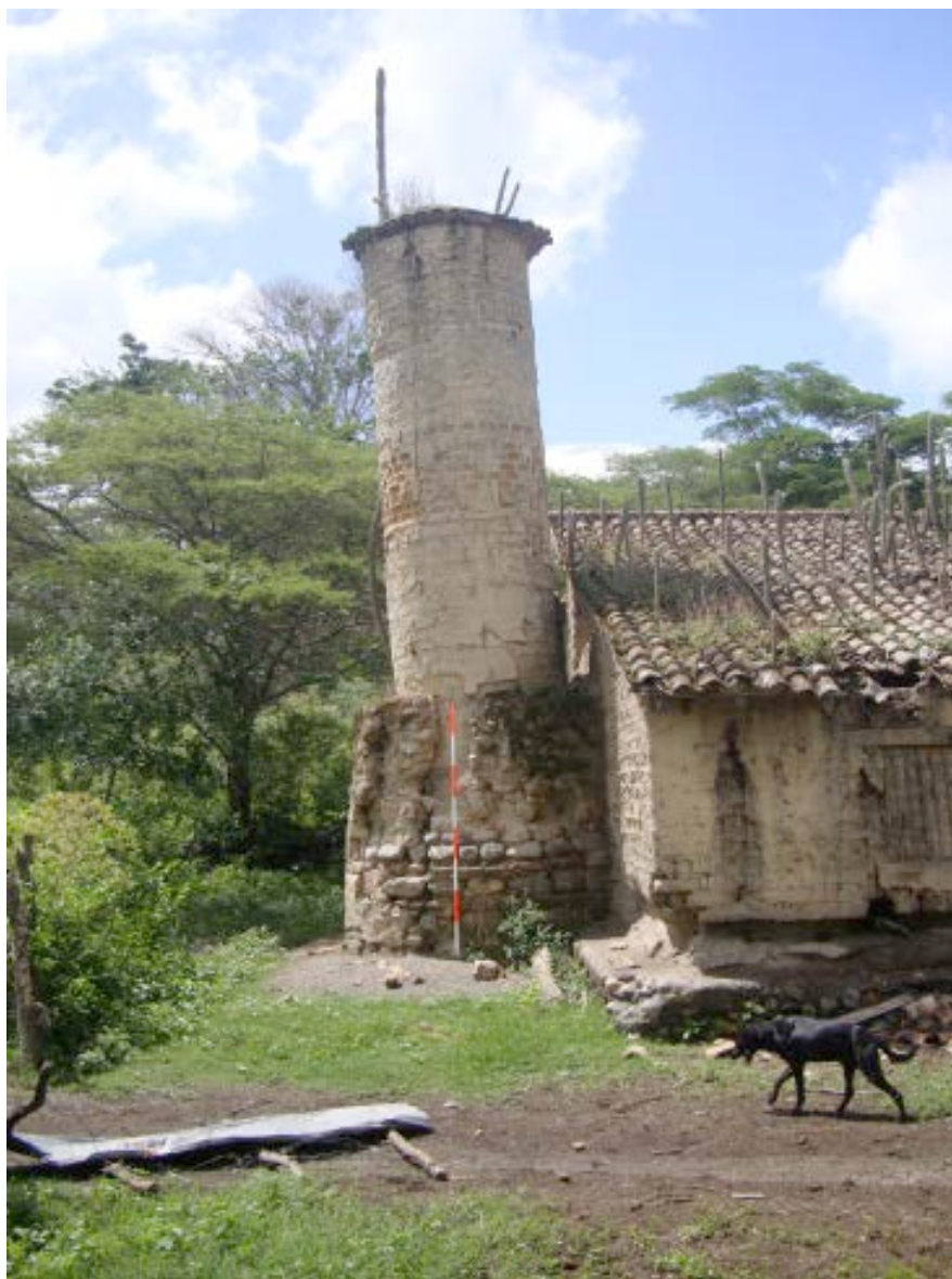
Fotografía 27: Trapiche Villa Rosa. Torreón.
