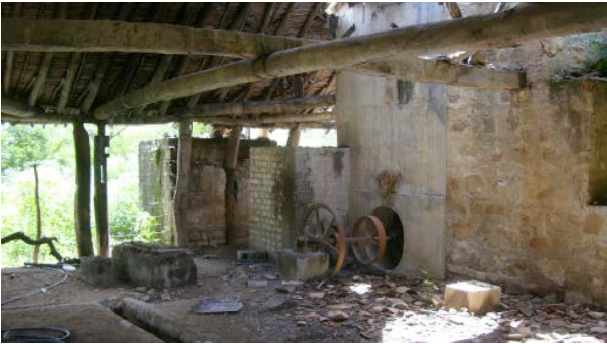
Fotografía 32: Trapiche Villa Rosa. Cuerpo de planta cuadrangular. Pedestales de la máquina de molienda y canal conductor del guarapo.
