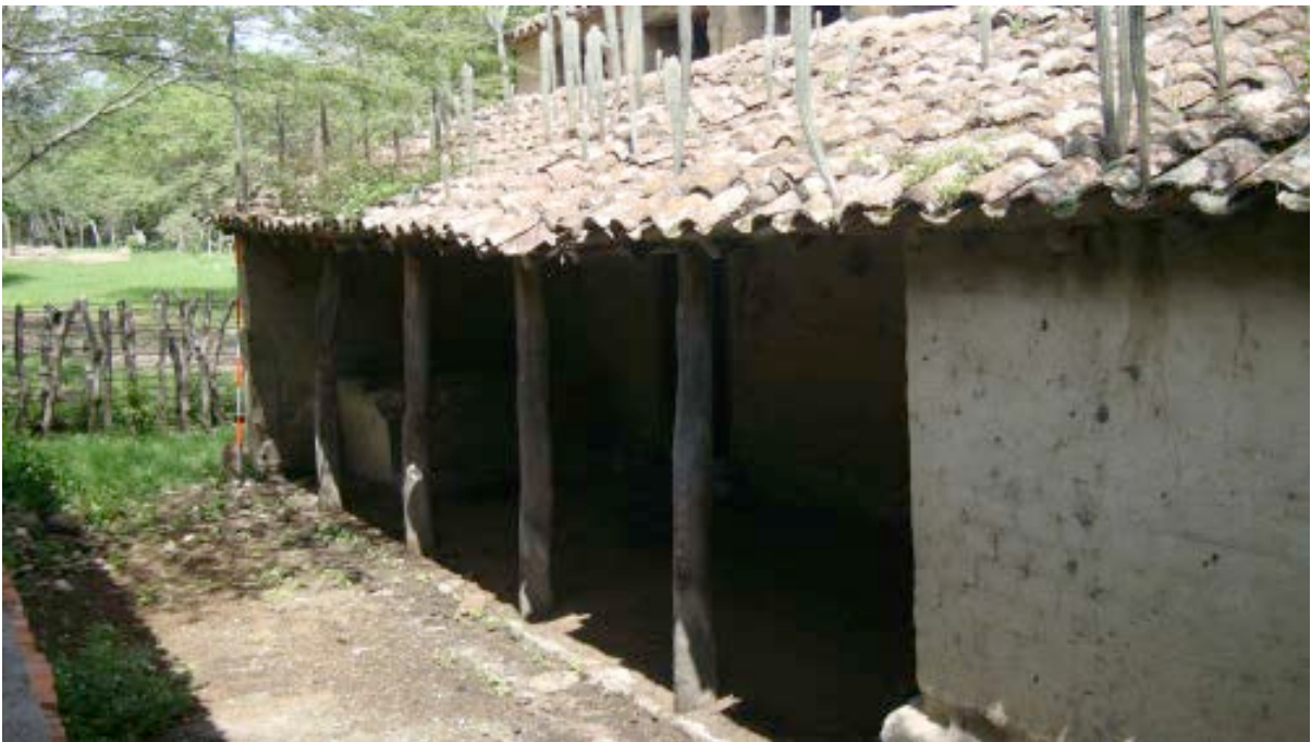
Fotografía 30: Trapiche Villa Rosa. Cuerpo de planta rectangular. Fachada oeste.
