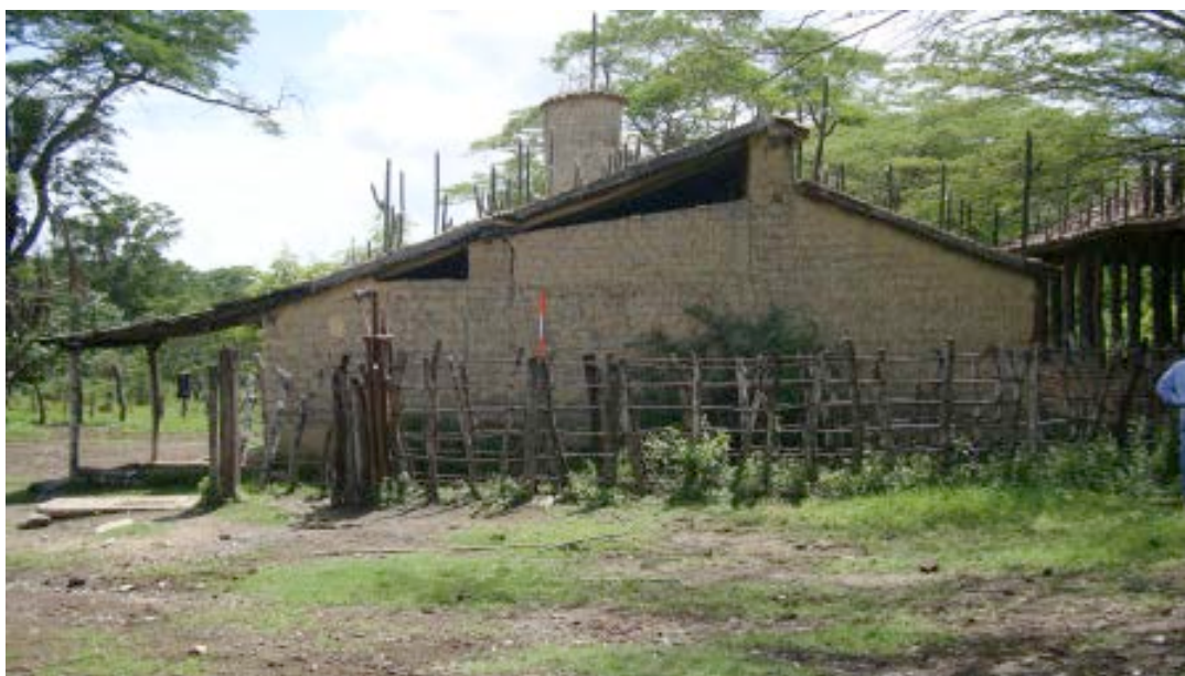
Fotografía 28: Trapiche Villa Rosa. Cuerpo de planta rectangular. Fachada sur.
