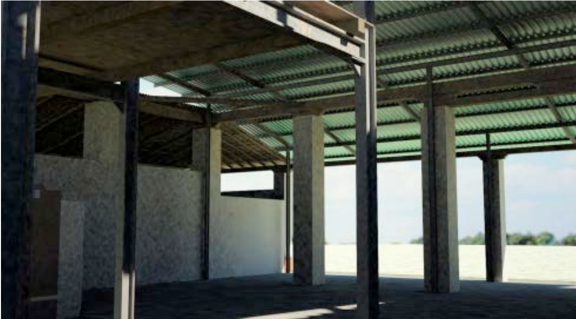
Imagen 1: Trapiche Santa Rita. Vista tridimensional de la estructura de techo del cuerpo sur.
