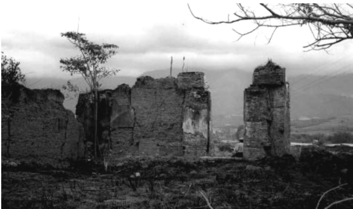
Fotografía 7: Ruinas de la casa de purga o “purguera”, fabricada en tapiería. Hacienda Casarapa, valle de Guarenas.
