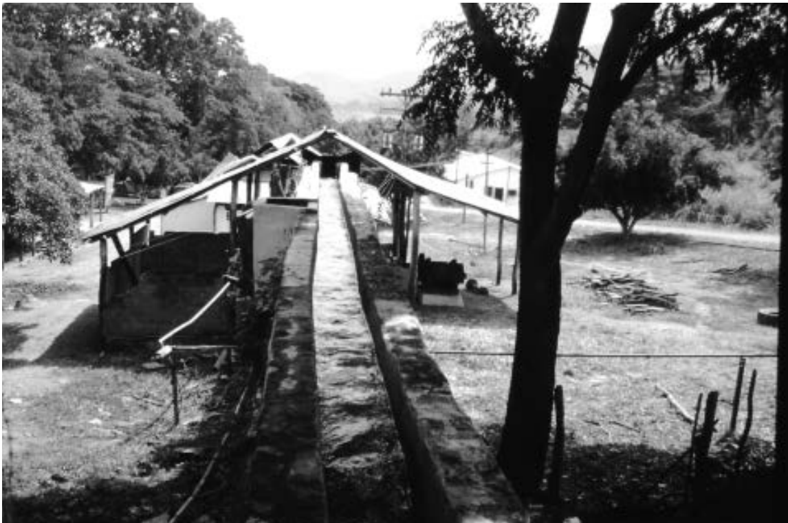
Fotografía 34: Trapiche La Pastora. Vista del acueducto y del área de molienda de la caña de azúcar.
