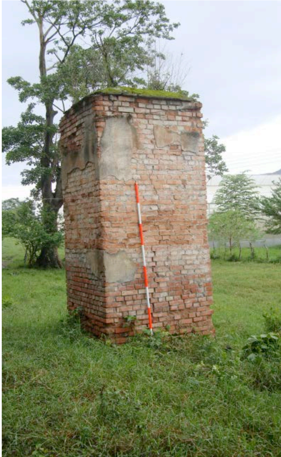
Fotografía 26: Trapiche El Ingenio. Torreón de ladrillos cocidos.
