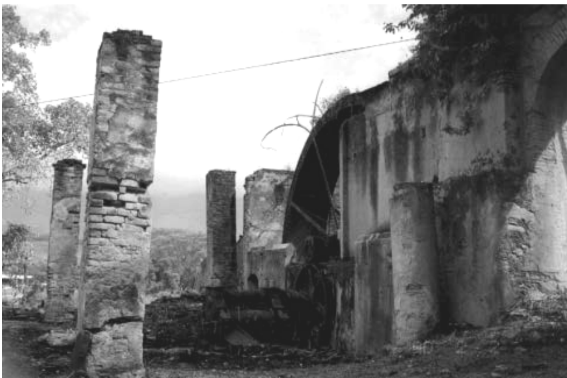
Fotografía 1: Trapiche con mazas horizontales en triángulo isósceles, movido por fuerza hidráulica. Hacienda Casarapa. Valle de Guarenas.
