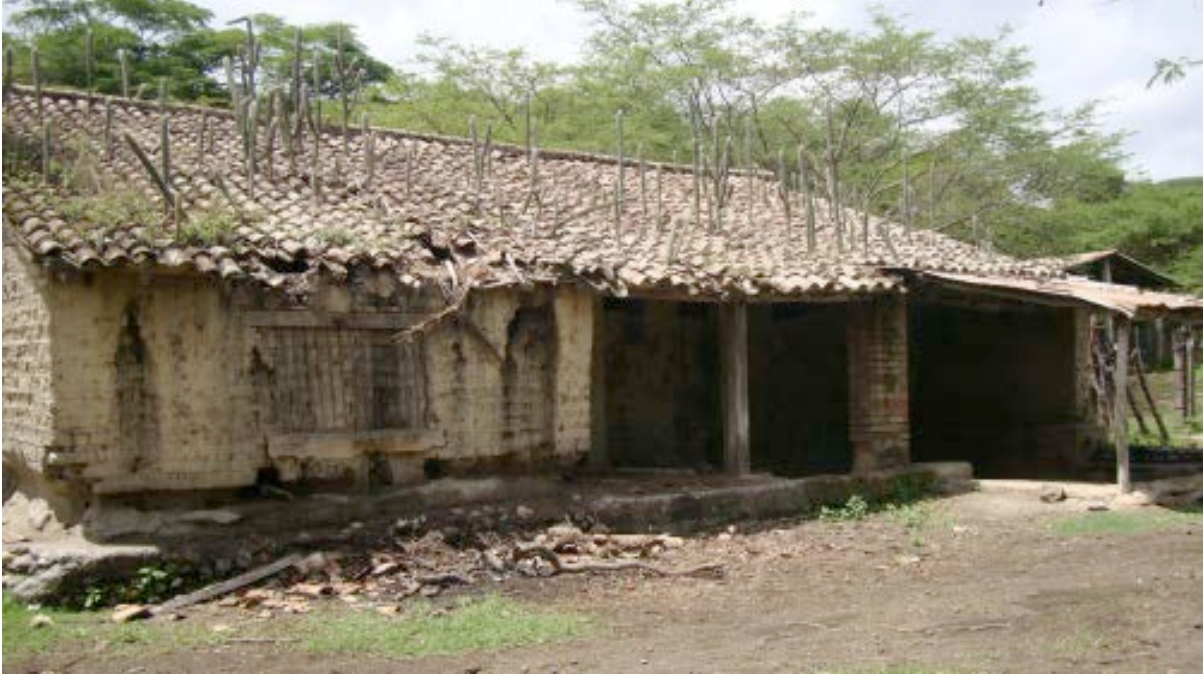
Fotografía 29: Trapiche Villa Rosa. Cuerpo de planta rectangular. Fachada oeste.
