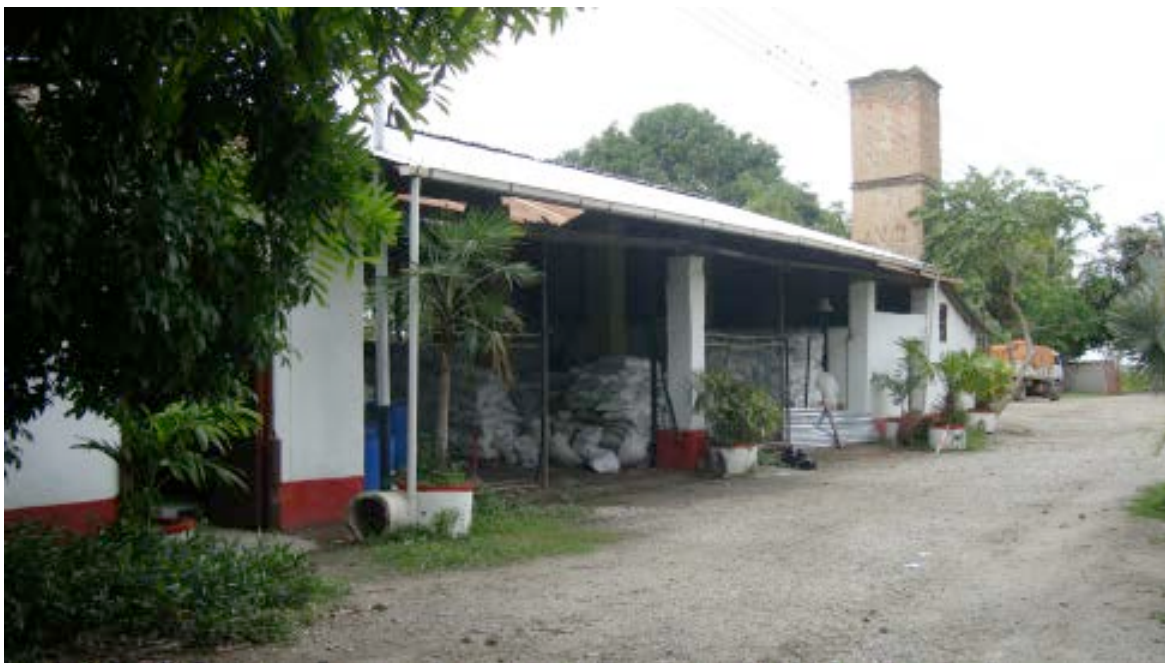
Fotografía 12: Trapiche Santa Rita. Fachada Sur.
