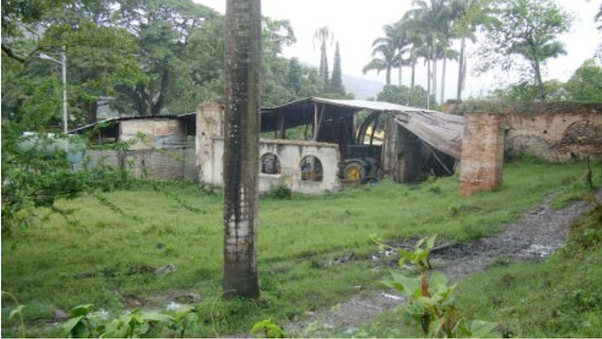
Fotografía 23: Trapiche El Ingenio. Fachada sur.
