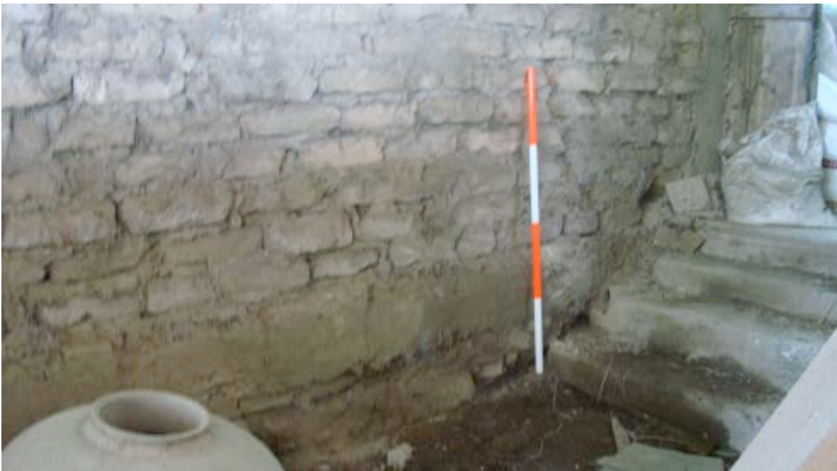
Fotografía 15: Trapiche Santa Rita. Pared interna, fabricada con adobes de tierra cruda.
