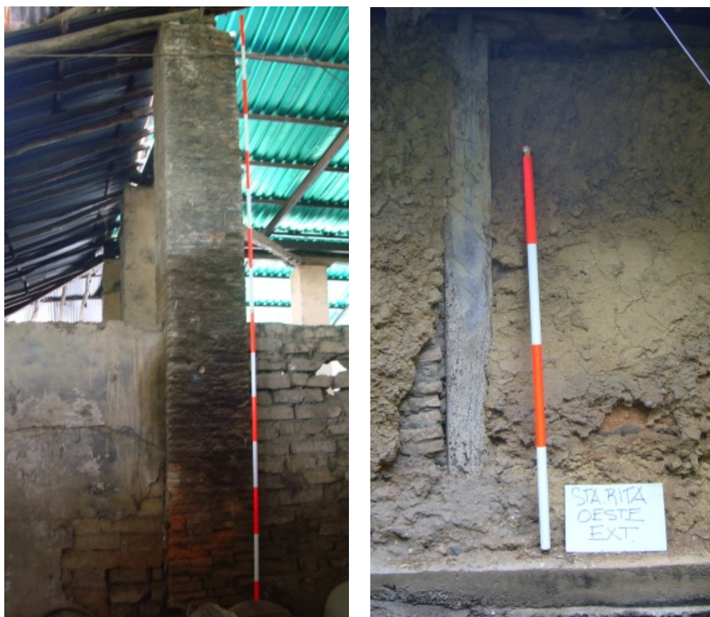
Fotografía 13: Trapiche Santa Rita. Izquierda: columna o pilar de ladrillo; derecha: horcón de sección cuadrangular.
