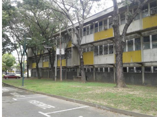
Figura II.3.1: Fachada lateral del Laboratorio de Hidráulica de la UCV. Fuente propia
