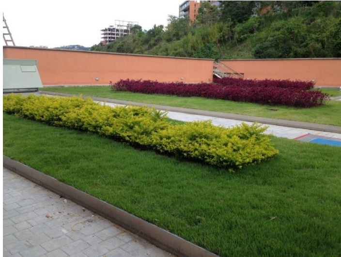
Figura 31 Techo Verde en edificación en la Alameda Caracas (Fuente Elaboración Propia)
