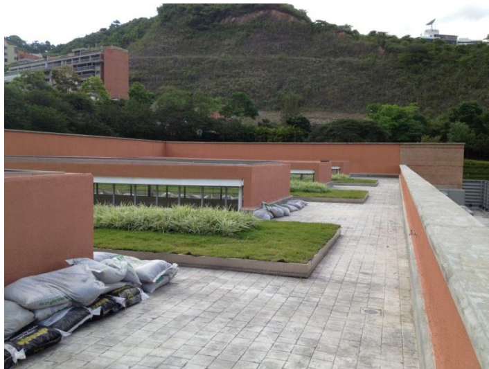
Figura 33 Distribución de Techo Verde por “pañós” en la Alameda, Caracas (Fuente Elaboración Propia)
