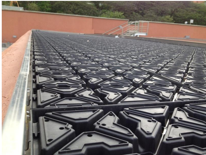
Figura 32 Paneles de drenaje utilizados en edificación comercial en la Alameda Caracas (Fuente Elaboración Propia)
