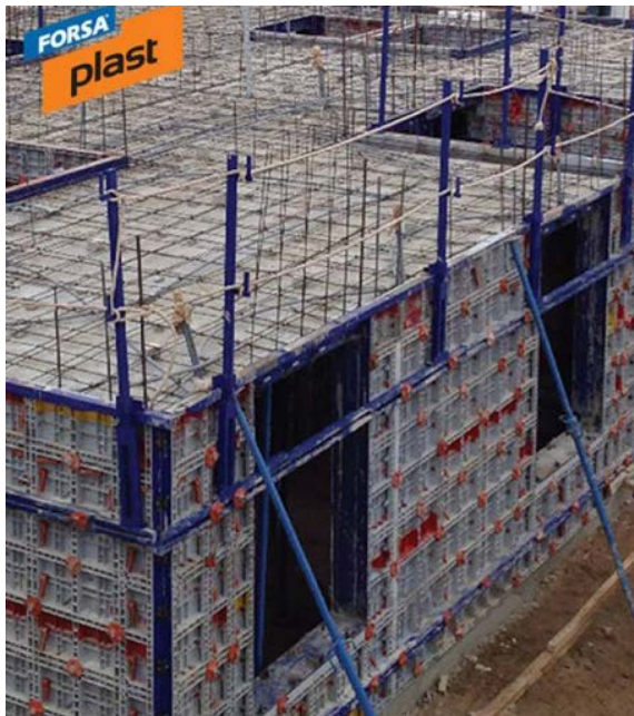
Fig. 6.- Encofrados de plástico fabricados por la empresa Forsa.
