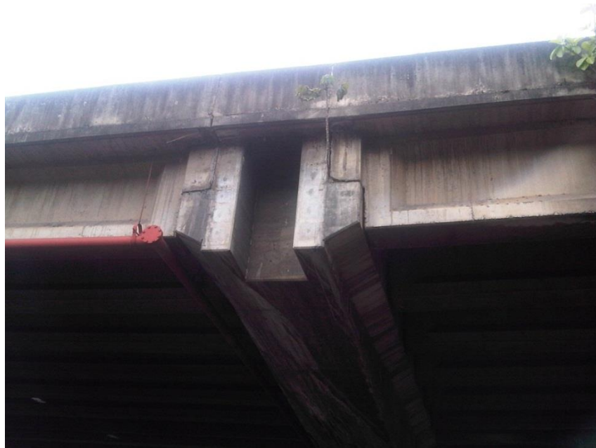
Imagen 4.7. Puente Veracruz II, Distribuidor El Ciempies-Las Mercedes. “junta de dilatación”. Fuente: Propia
