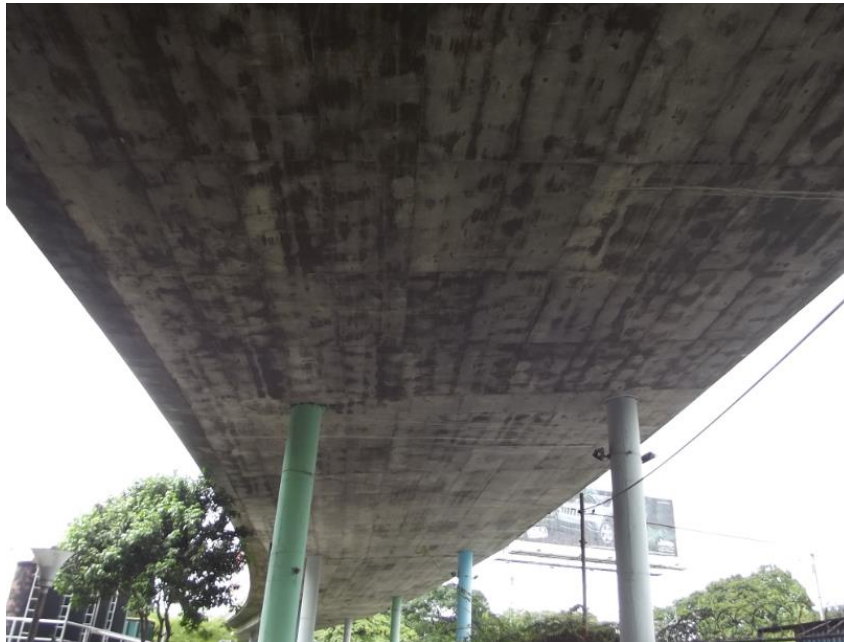
Imagen 4.3 Tramo elevado “Autopista Valle-Coche, rampa El Pulpo (tramos 20-23) Tipo losa viga cajón”. Fuente: Propia
