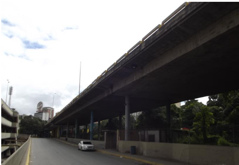
Imagen 4.1 Tramo elevado “Autopista Valle-Coche, rampa El Pulpo (tramos 20-23) Sistema Pórticos”. Fuente: Propia
