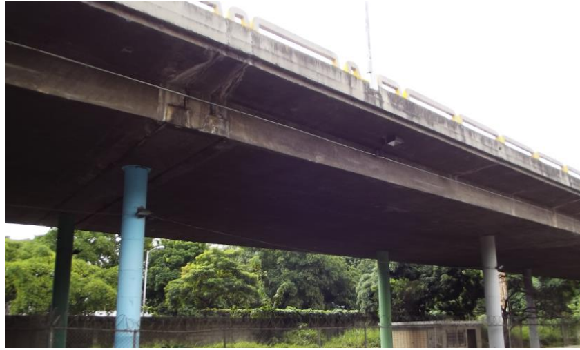
Imagen 4.4 Tramo elevado “Autopista Valle-Coche, rampa El Pulpo (tramos 20-23) Juntas de dilatación”. Fuente: Propia
