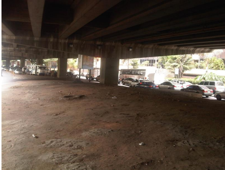
Imagen 4.6. Puente Veracruz II, Distribuidor El Ciempies- Las Mercedes. “sistema monocolumna”. Fuente: Propia
