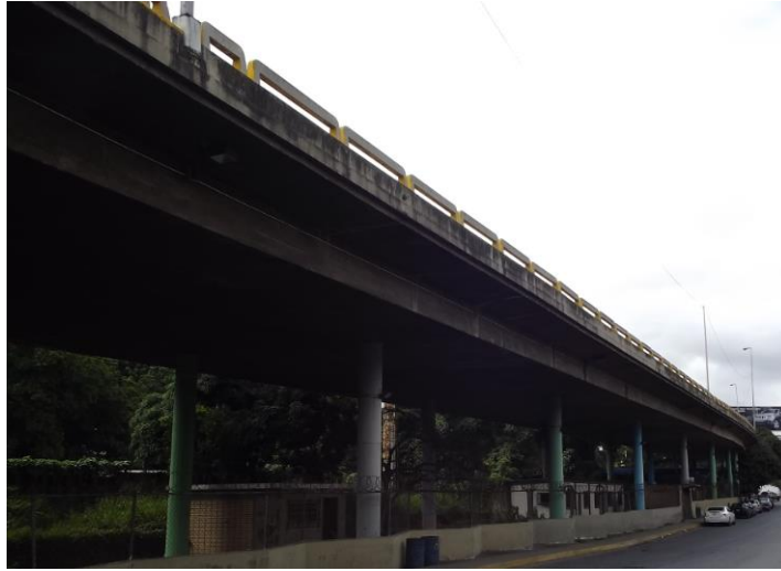
Imagen 4.2 Tramo elevado “Autopista Valle-Coche, rampa El Pulpo (tramos 20-23) Sistema de Pórticos”. Fuente: Propia
