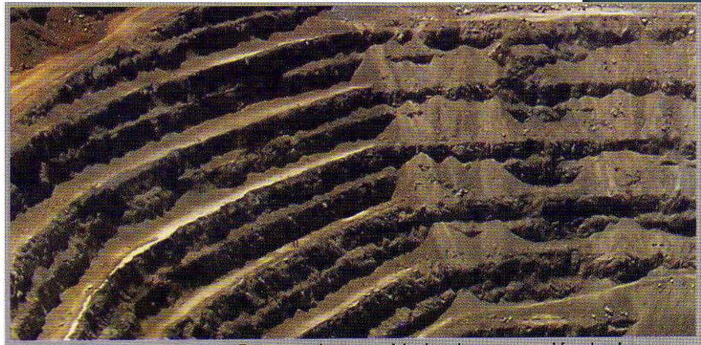
Bermas de seguridad o de contención de derrames
