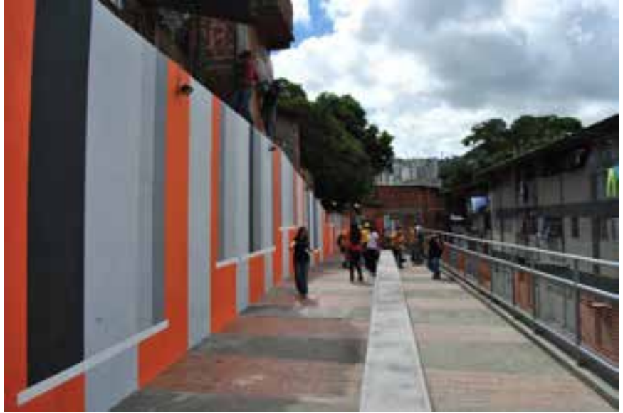
FIGURA 81. Vista, Bulevar Guaicaipuro.
