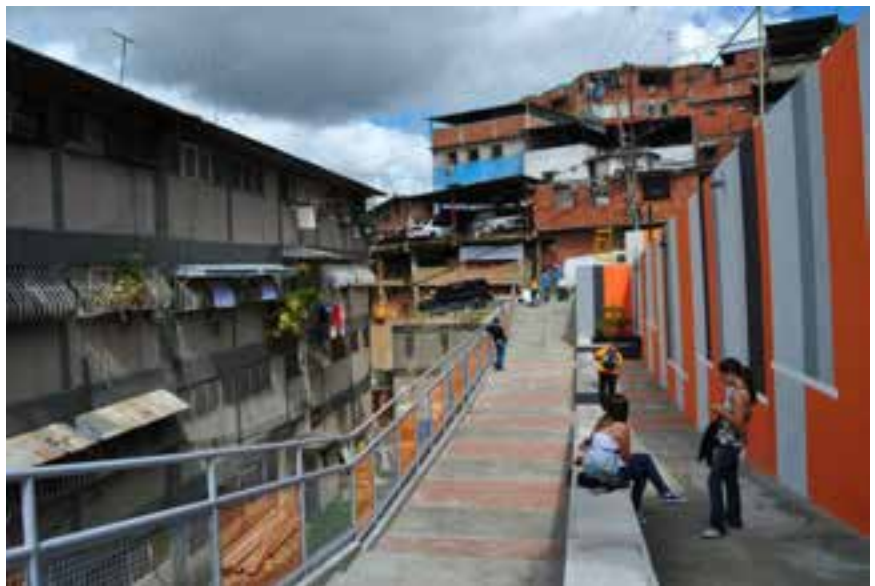
FIGURA 82. Vista, Bulevar Guaicaipuro.
