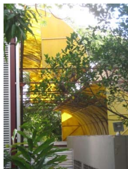
Imagen N° 3. Fotos de los tabiquería con paramento obra limpia de bloques de concreto con arena amarilla, ½ bóvedas de fibra de vidrio, romanillas fijas de aluminio.
