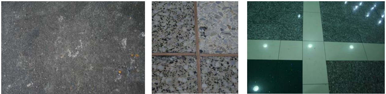
Imagen N° 6. Foto revestimientos de pavimentos exterior e interiores (granito vaciado con flejes plásticos y granito vaciado combinado con mármol y cerámica). Fuente: Morela Quintero y Juan Luís Marcano
