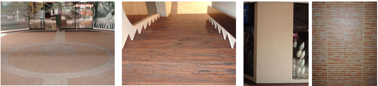
Imagen N° 17. Fotos pavimento exterior de canto rodado y puertas de vidrio, escalones revestidos de mármol pulido y paramentos de estuco y piezas pequeñas de arcilla Fuente: Alejandro Ordaz y Peter Havriluk
