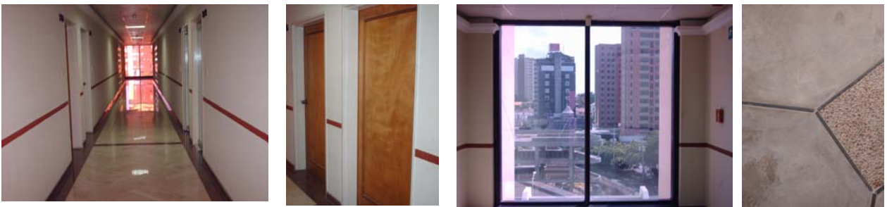
Imagen N° 18. Fotos pavimento de porcelanato, puertas, ventana y baldosas de piso. Fuente: Alejandro Ordaz y Peter Havriluk
