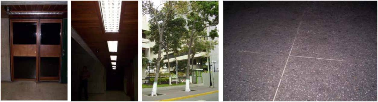
Imagen N° 15. Fotos puertas y cielorrasos de madera, ventanas desde exteriores, y pavimento de granito vaciado en sitio.
