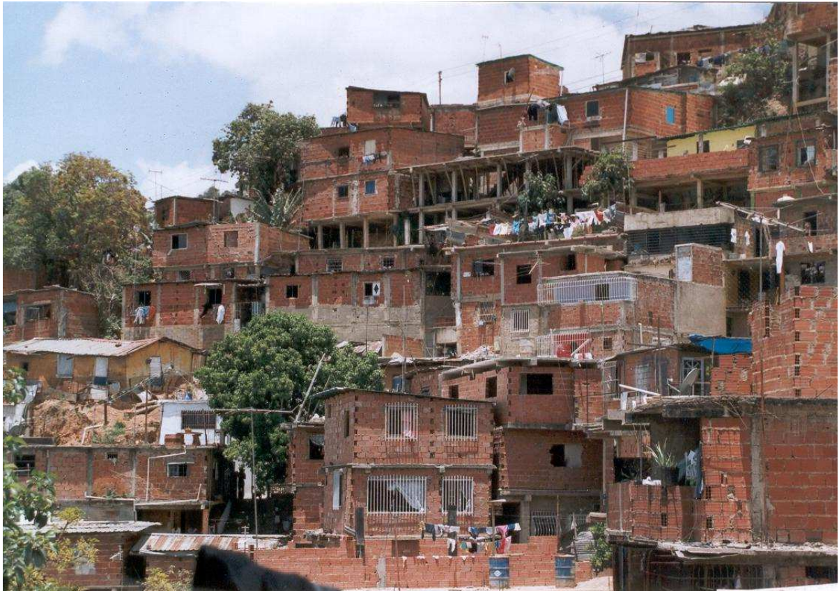
En esta imagen vemos como a pesar de la irregularidad y diversidad de los volúmenes y las diversas relaciones entre unos y otros; pareciera que los elementos estructurales (vigas y columnas de concreto a la vista), cerramientos de bloques de arcilla sin revestir y el tamaño de los vanos de ventanas, al ser los mismos, generan una imagen de uniformidad, que bien podría representar cualquier asentamiento de la ciudad. Nótese cómo se aprecian edificaciones en diferentes estadios de su construcción. Barrio San Blas, Petare Sur. Marzo, 2002. Imagen: Y. Martín.
