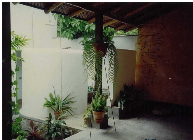
La ducha vista desde el corredor (foto tomada durante el proceso de pintura de la obra).
