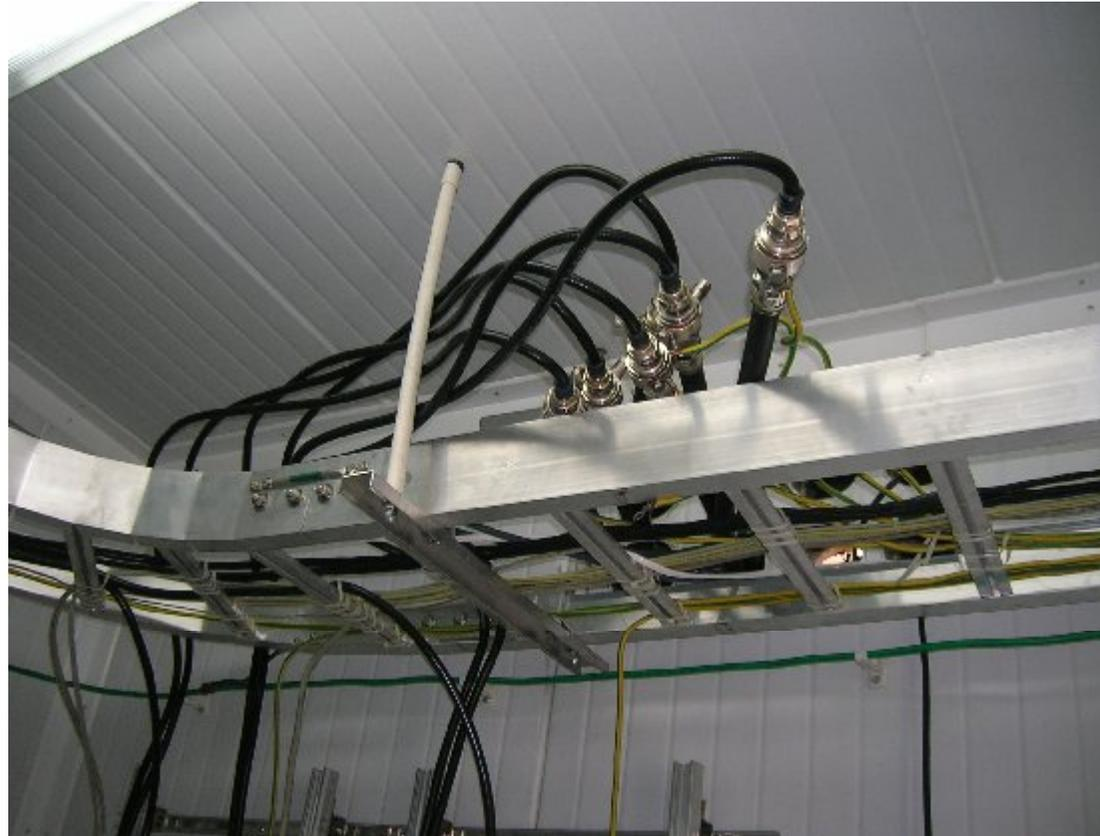
Conexión Jumper 1/2 " & Feeder 1/8"
