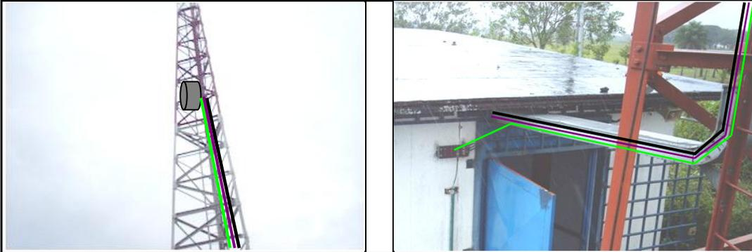
Los cables bajaran de la torre por la cara entre las aristas a y b. Para entrar al shelter se internarán el ducto dispuesto. La puesta a tierra de la ODU se llevará a cabo en la barra de tierra en la entrada del shelter, ya que la torre no posee barra.
