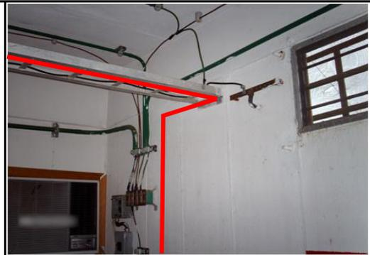
La flecha en la foto de la izquierda muestra el toma corriente a ser utilizado por la IDU. La IDU también podría ser conectada a un inversor conectado a un banco de baterías.\*
