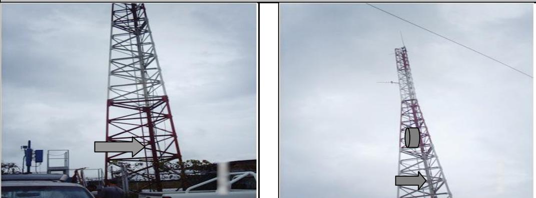
La antena será colocada en la arista A señalada por las flechas en las imágenes, a una altura de 36 metros.
