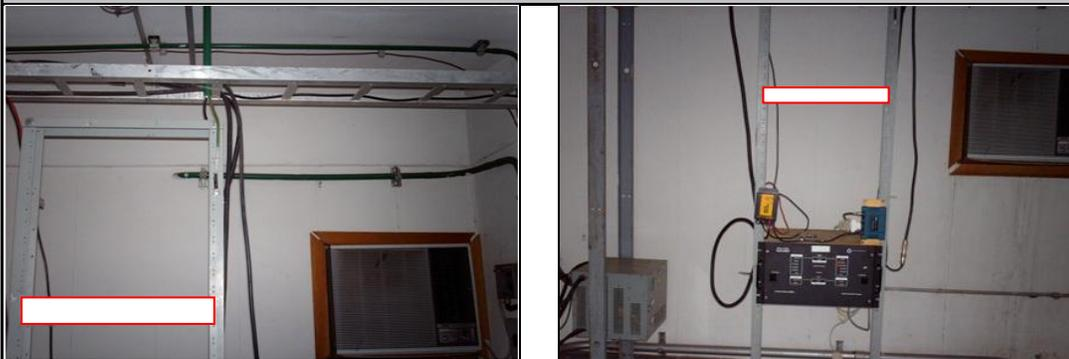
En la fotografía se observa el rack disponible para la instalación. El rack es de 19". El rack se encuentra conectado al sistema de puesta a tierra.
