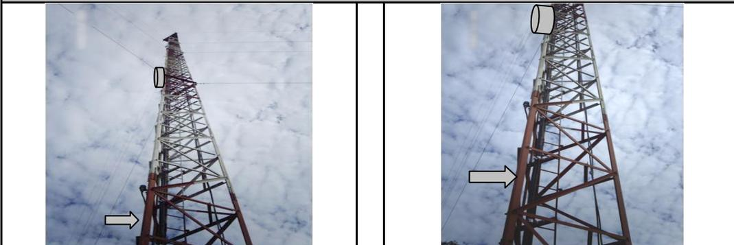
La antena será colocada en la arista A, la cual es señalada con las flechas. La altura de la antena será de 26 metros.
