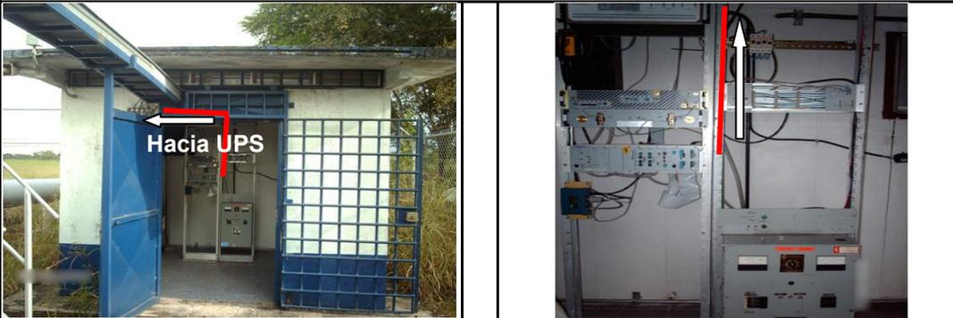
El recorrido del cable de energía se llevará a cabo por las escalerillas existentes hasta el cuarto adyacente, por medio de tubería Conduit, donde se encuentra el UPS. La información será ampliada en la sección RESUMEN DE INSTALACIÓN.
