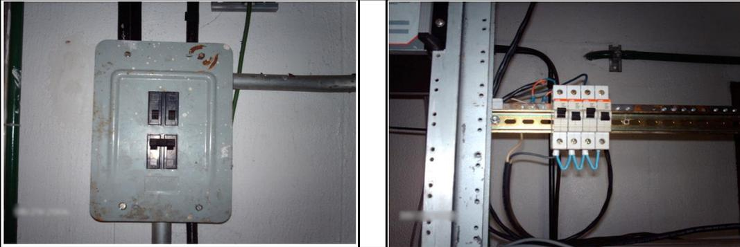
En la fotografía de la derecha se observa un panel de breakers AC y en la de la derecha breakers correspondientes a +24VDC instalados en el rack de la derecha. Ninguno de estos breakers serán utilizados para la instalación.
