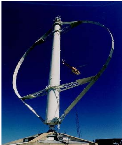
Ilustración 5. Aerogeneradores de eje vertical
