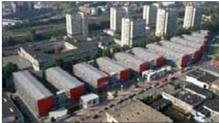
Fig. 1.9. Urbanismo compuesto por Edificios construidos a base de contenedores Tempohousing®. Fuente: http://www.tempohousing.com/projects/keetwonen.html
