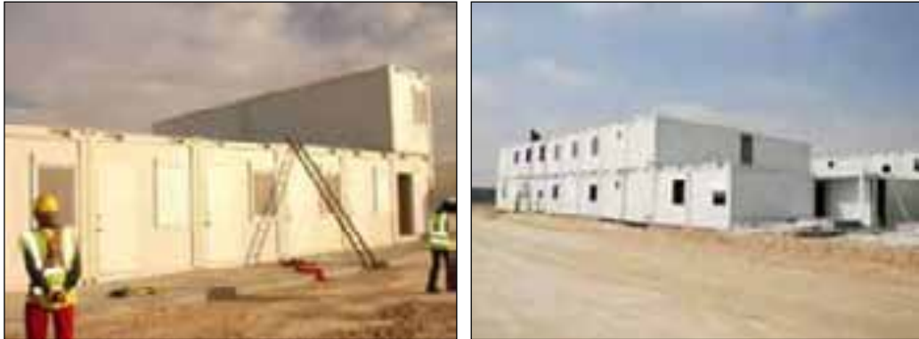
Fig. 1.5. y Fig. 1.6. Construcción de Viviendas Multifamiliares. Star House®, Sangai.
