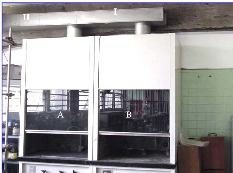
Figura 3.8 Sistema de Extracción 1 (LFS)
