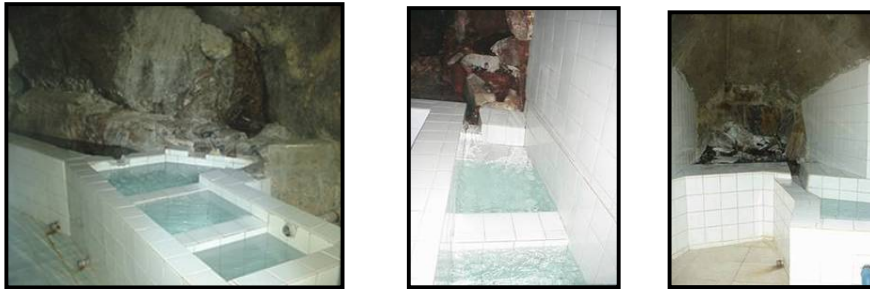
Figuras 2.12, 2.13 y 2.14. Algunos de los Manantiales de la Planta San Pedro
