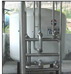
Figura 2.8. Filtro de Carbón
