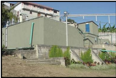
Figura 2.3. Tanque de Almacenamiento del Agua de Pozo
