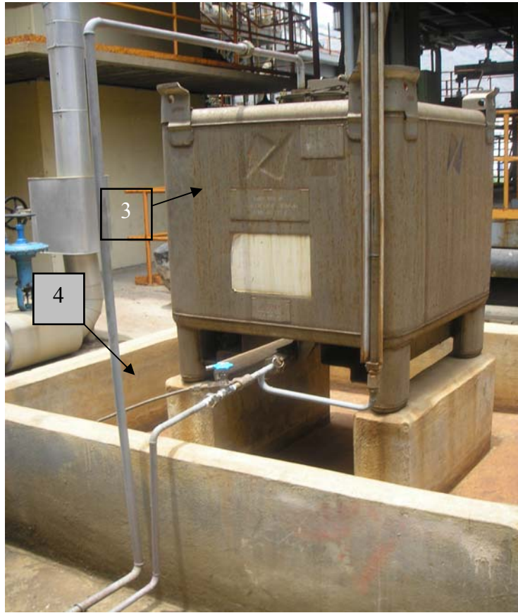
Fig. n°17 Tanque de hidracina al 35% nivel desaereadores. Fuente: propia.
