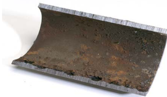
Figura n°11. Corrosión bajo depósito
