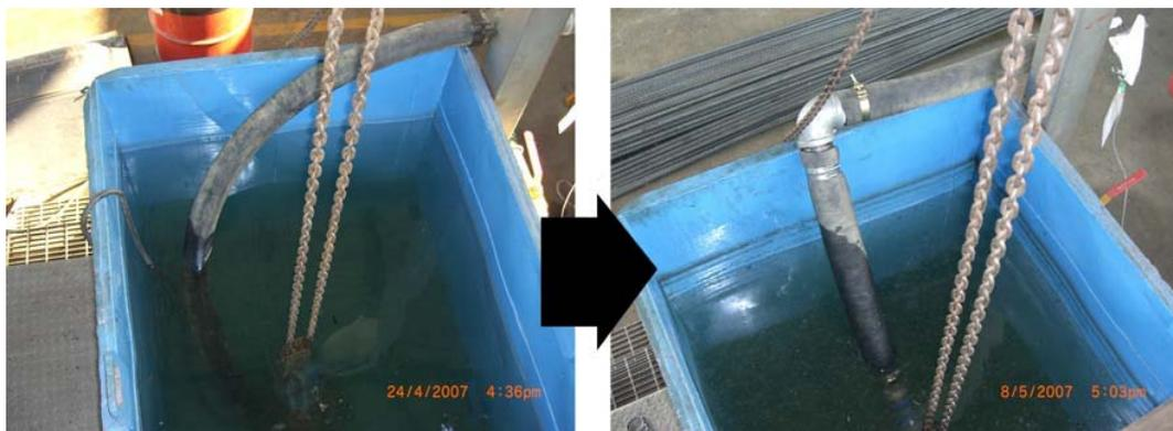
Fig. 69 - Cambio de manguera de conexión.
