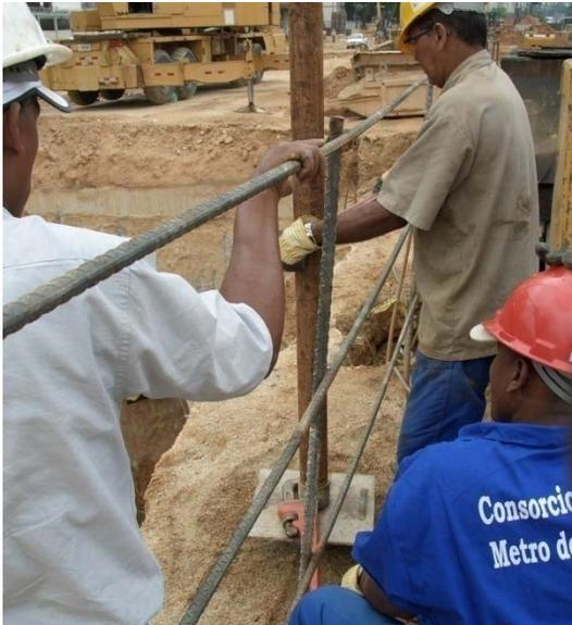
**Fig. 32 - Proceso de enrosque de tubería a conjunto inferior.**
