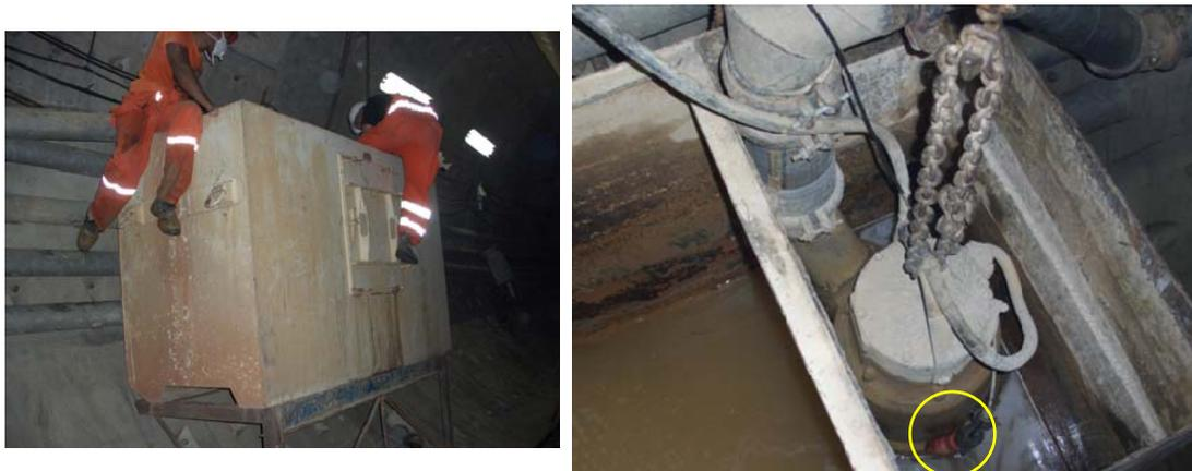
**Fig. 36 - Estación de bombeo para agua de desecho.**
