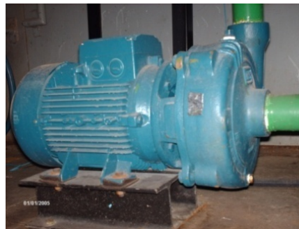
Figura 15. Bomba de Suministro de Líquido del Banco experimental de Flujo Bifásico.
