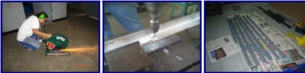
Figura 4.1.- De izquierda a derecha: Tronzado, taladrado y ángulos esmerilados y pintados con fondo anticorrosivo
