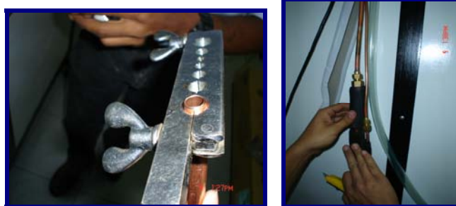
Figura 4.7.- Instalación de las tuberías de cobre
