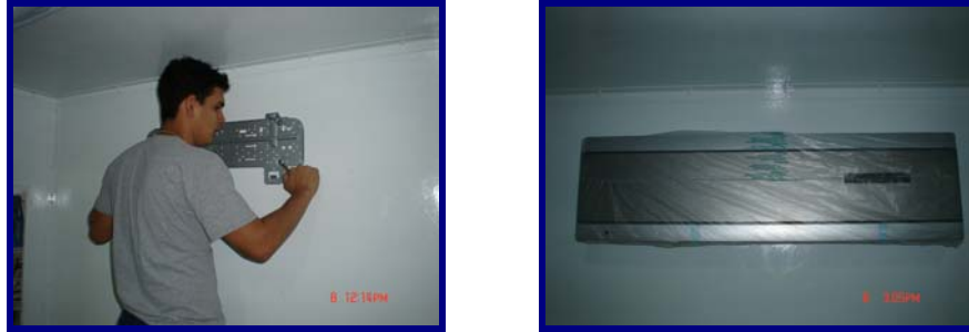
Figura 4.6.- Instalación de la unidad interior
