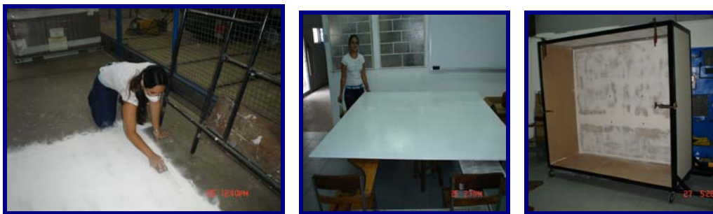
Figura 4.4.- Proceso de instalación de las láminas de yeso
