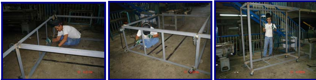
Figura 4.2.- Proceso de soldadura de la estructura del banco de pruebas
