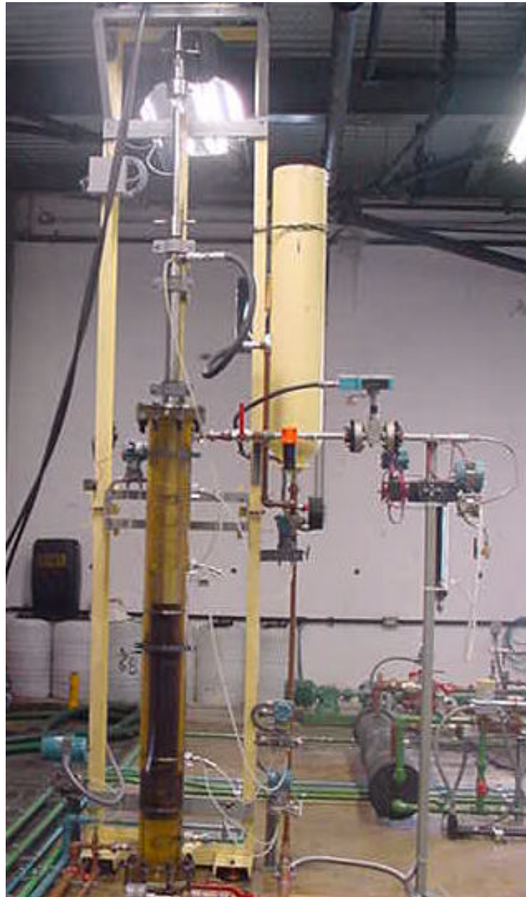
Figura 58. Prueba de válvulas con la bomba de doble pistón.
