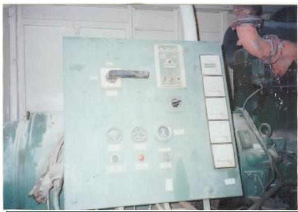
**Fig. 3.3.** Detalle del Control del Generador
