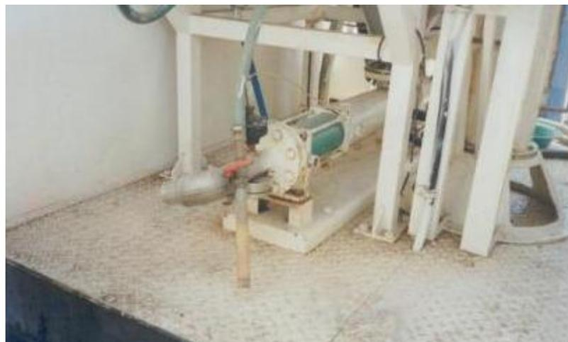
**Fig. 3.10.** Bomba de Cavidad Progresiva
