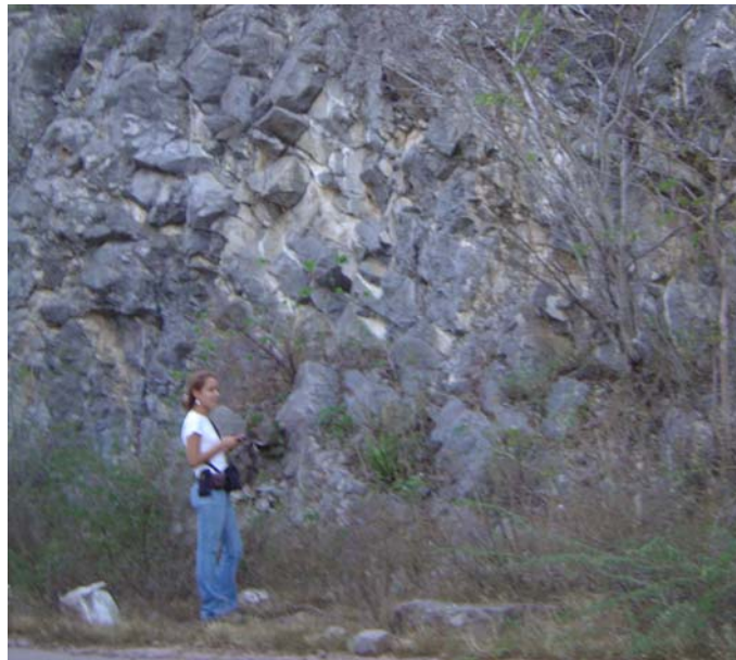
Figura 3.83 Afloramiento de calizas de la Formación Churuguara, ubicado en la zona 6248-I, de baja frecuencia de diaclasamiento, rumbo de la foto N25O.
