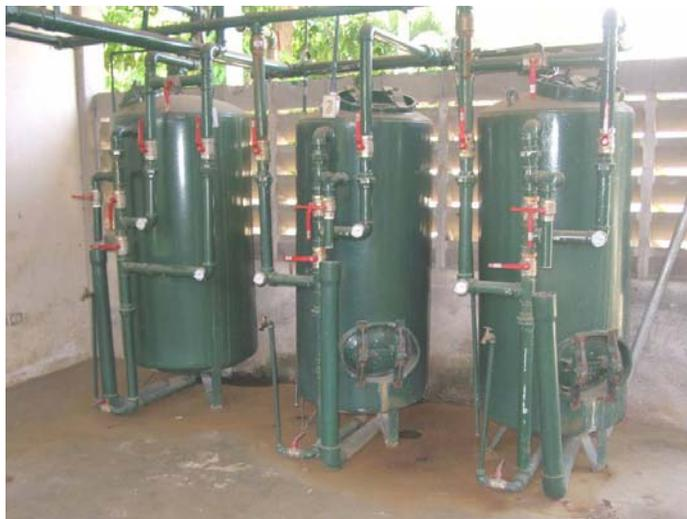
Figura 10. Filtros externos. Tratamiento físico al agua de alimentación.
