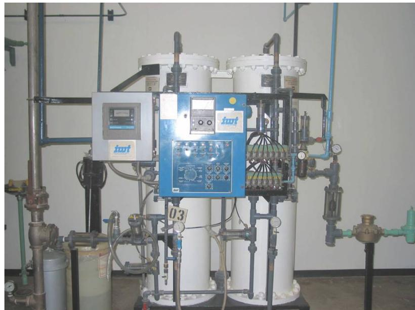
Figura 4. Equipo desmineralizador actual.
