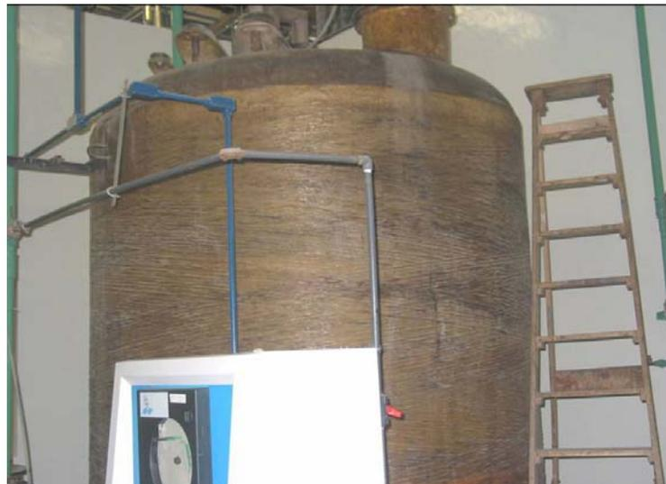
*Figura 6. Tanque para clorinación. Cap. 10.000 L*
