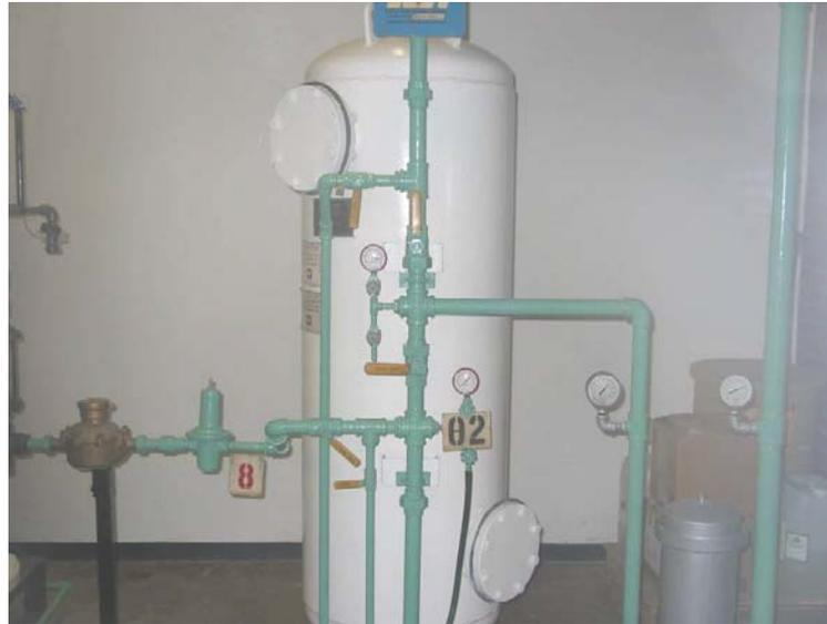
*Figura 5. Filtro de carbón activado.*
