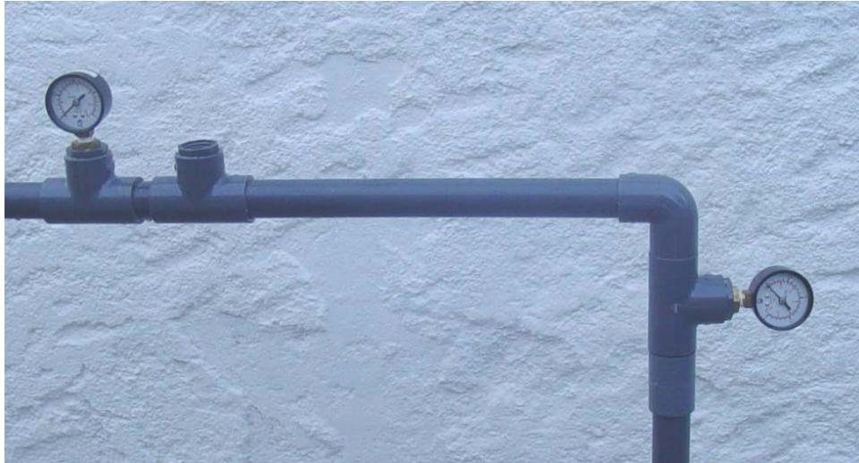
**Fig. 5.7.** Disposición de los manómetros.
