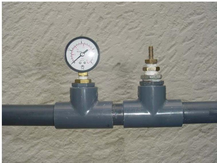
**Fig. 4.12.** Detalle del conjunto manómetro y eyector.
