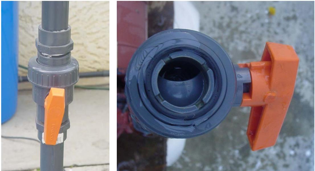
Fig. 4.13. Válvula de PVC de 1”.
