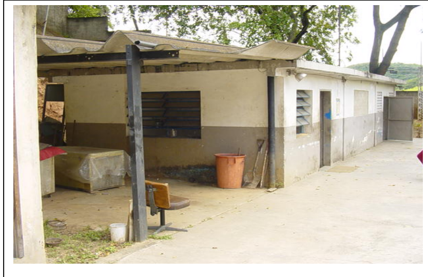
Figura 4.4 Estación de Bombeo Yaguara II
