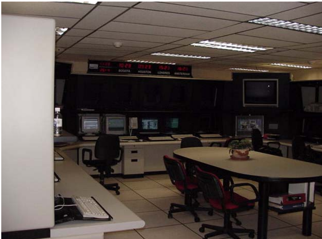
Sala de Control (Área 2)
