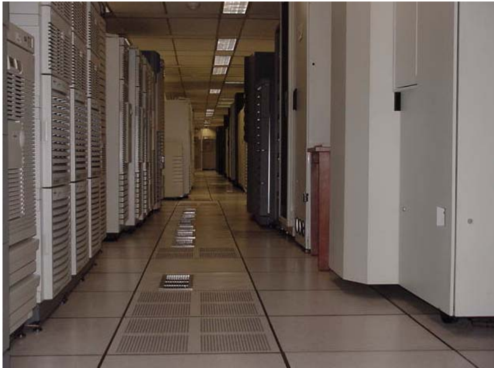
Vista del Área 1
