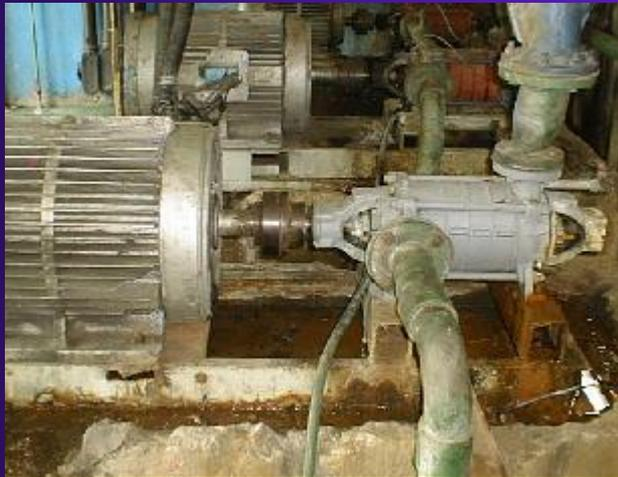
Detalle del deterioro de las bases metálicas
