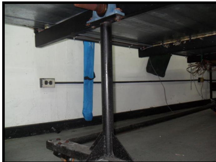
Figura 4.7 “Apoyos de la estructura soporte del colector solar”
